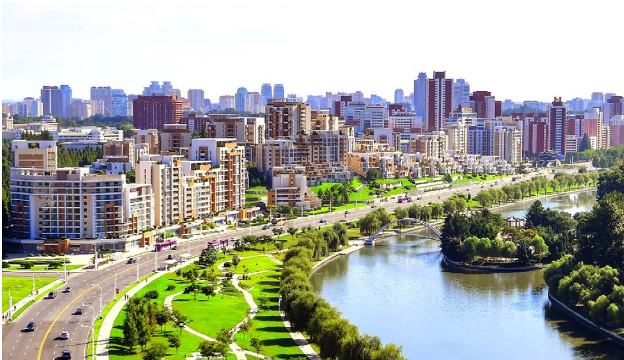
64. Террасный жилой сектор на набережной реки Потхон.
