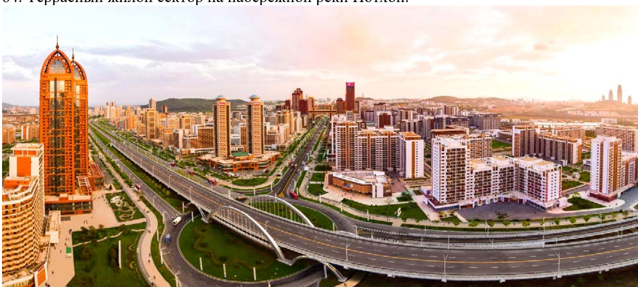
65. Часть новопостроенных жилых домов в районе Хвасон.
