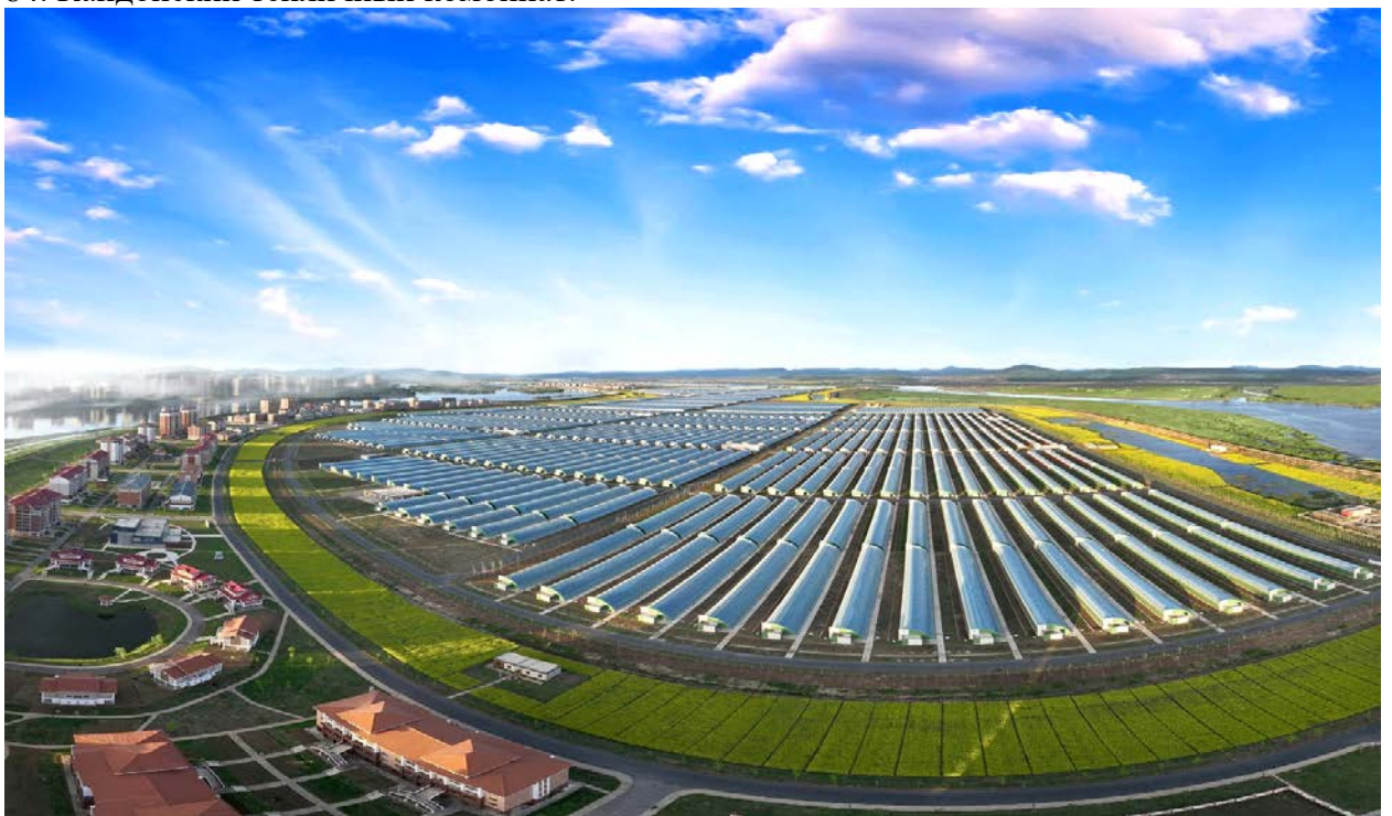
85. Синичжуский тепличный комбинат.
